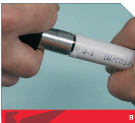
Dopo la calibrazione, e prima del montaggio del raccordo, si deve verificare che all’interno del tubo non siano presenti residui dell’operazione svolta, quali bave di materiale o sporcizia in genere.
